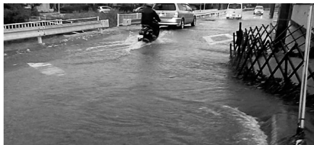
道路冠水状況
