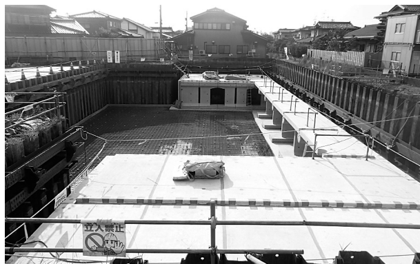
施工状況（令和元年8月）
