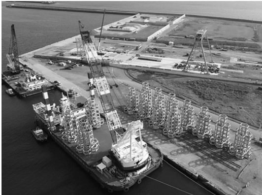
写真-1 大型魚礁を550 t旋回起重機船で積み込み
