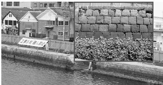
写真-5 大正・昭和時代築造の元船町の石積岸壁
