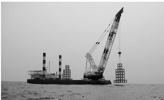
写真-2 水深130mの沖合に設置
