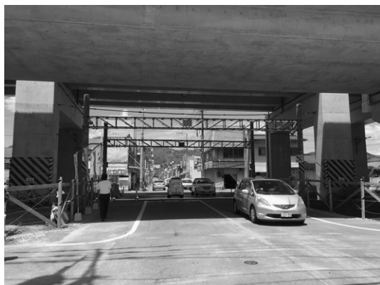
写真-2 高架化後の本妙寺踏切
