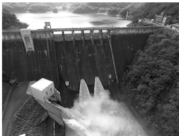
写真-2 高圧放流設備による放流
