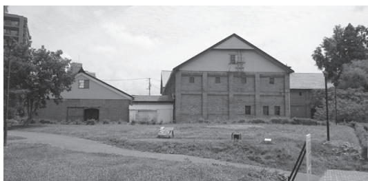
改修前の吉野町煉瓦倉庫
