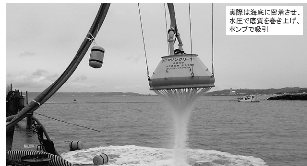
密閉吸引式底質除去装置（試運転状況）
