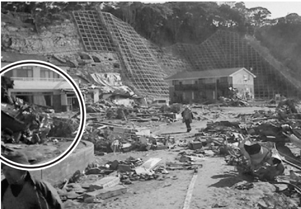
写真-1 消防団ポンプ車被災状況 (写真左)
