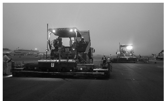
写真-1 舗装工施工状況
