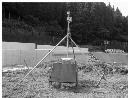
写真-2 基準局設置状況
