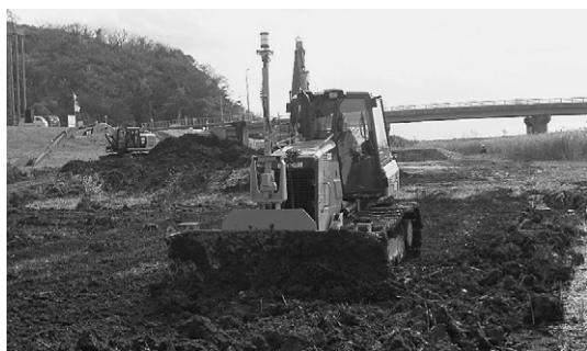
写真-1 情報化施工実施状況（ブルドーザー）
