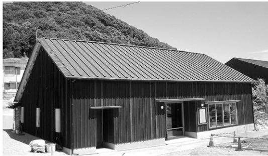
写真-3 空き家再生等推進事業を活用した「三風舎」
