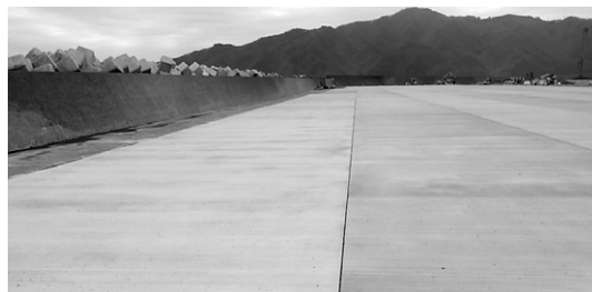
野積場完成後(高上げにより路面排水機能を回復)
