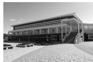
北側からの外観
