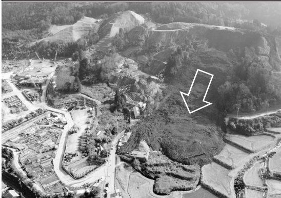
写真-1 大阪府豊能町での土砂崩落事案
