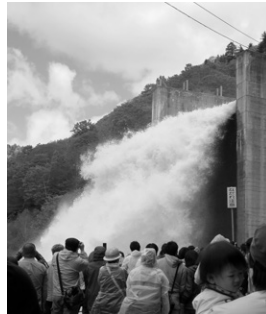
矢木沢ダム点検放流
