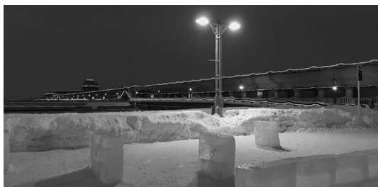
防波堤イルミネーション
