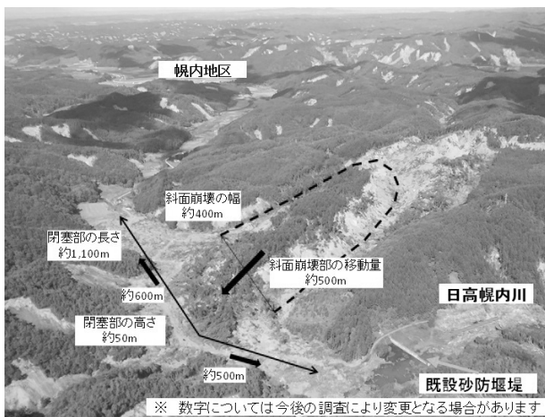
日高幌内川河道閉塞状況
