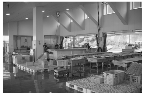
写真－3 熊野市衛生管理型水産物荷さばき施設
