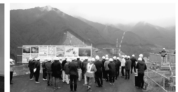
現場研修の様子 小石原川ダム建設現場
