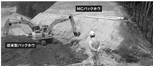
写真-1 MC、従来型BHの作業分担を設定
