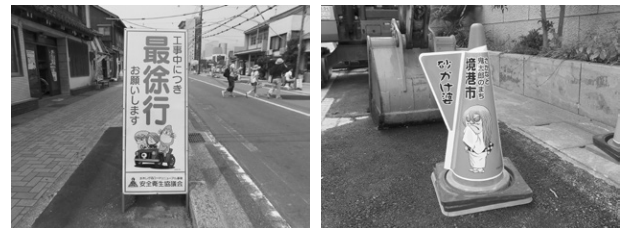
写真-3 工事看板等
