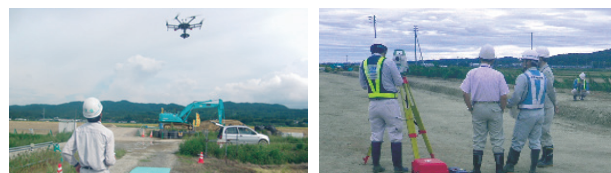
写真－6 出来形測量状況 写真－7 現場確認検査状況
