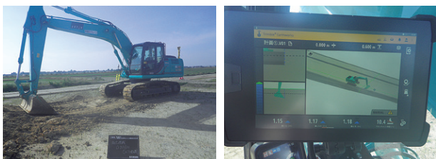
写真－4 使用機械(バックホウ) 写真－5 モニター状況
