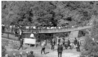
現場研修の様子「本宮砂防堰堤」
