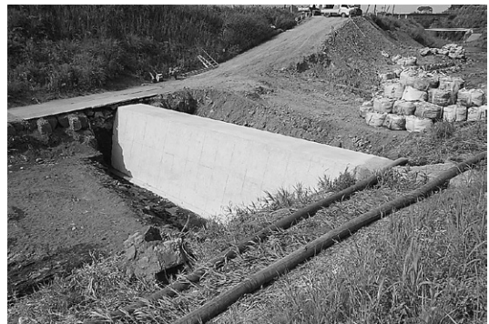
落差工施工状況
