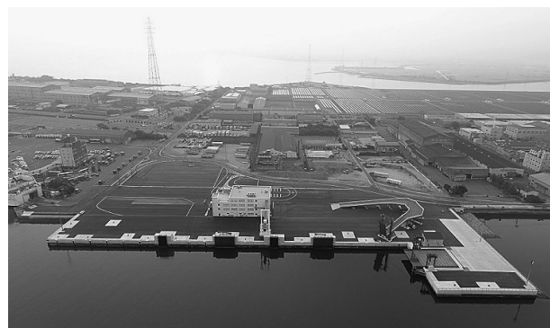
完成した耐震強化岸壁の全景
