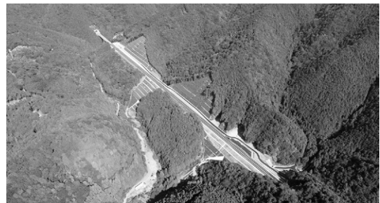
ICTを活用した土工・舗装工事で仕上げた工区
