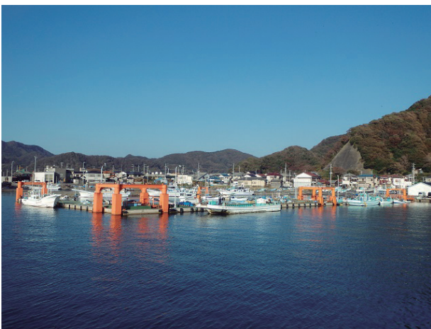
写真-1 省力化施設 浮棧橋
