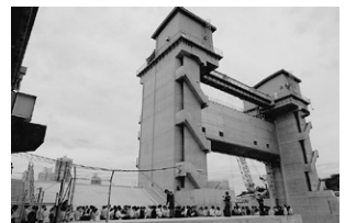
現場研修の様子「和歌山下津港 建設技術調整室 和田室長の講演の様子 海岸 海岸保全施設整備事業」
