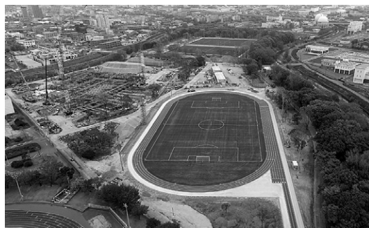
整備が進む中央緑地（左端が建設中の体育館）
