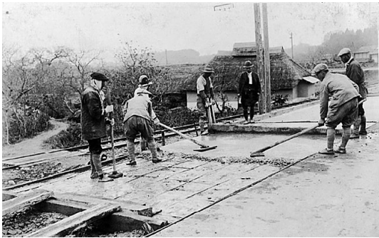
写真-6 コンクリート舗装状況の記録写真
