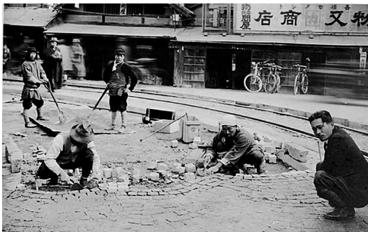
写真-7 敷石作業状況の記録写真
