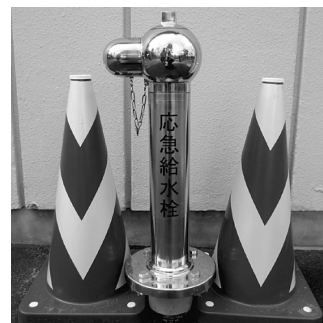
写真-1 応急給水栓
