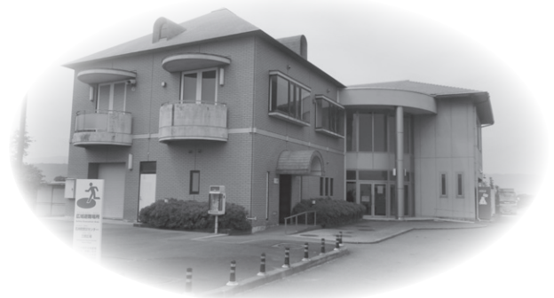
写真-2 防災センター
