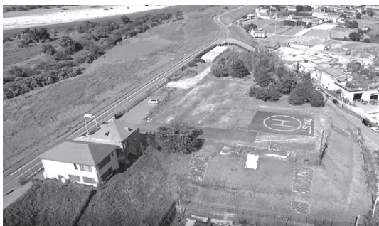
写真-1 石井地区河川防災ステーション
