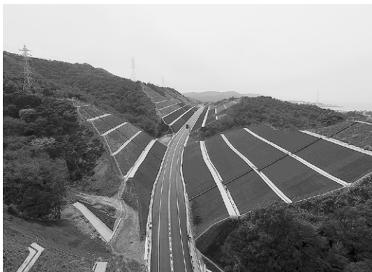
写真-1 現場全景
