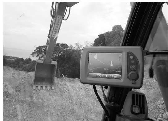
写真-2 切土作業状況写真
