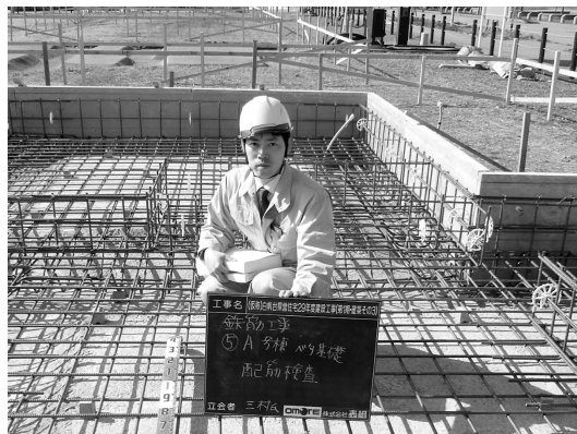
木造の県営住宅の工事現場にて
