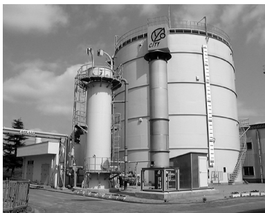
精製塔とガスホルダ（長岡中央浄化センター）
