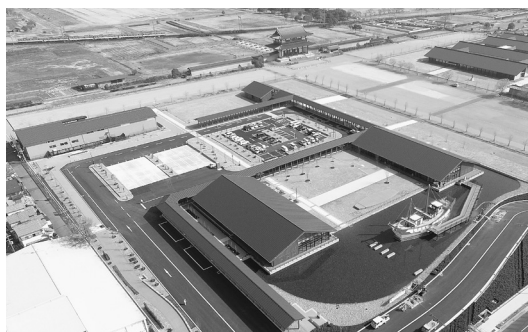
ドローン空撮写真（開園10日前）
