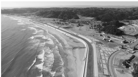
写真-1 復旧が完了したいわき市豊間地区 多重防衛として海岸堤防、県道、防災緑地を整備 (福島県土木部発刊「浜通り地方の復旧・復興加速化事業概要より」)
