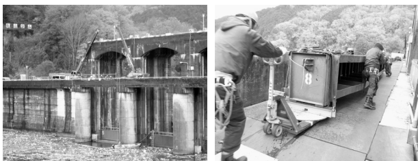
写真-2 角落し設置状況
