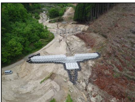
①仮設砂防堰堤工
