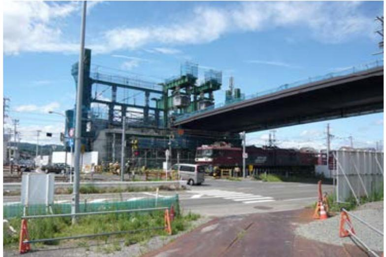
なお、橋梁形式は、JR東北本線横断部が単径間鋼床版箱桁橋（橋長 $L=42.8\text{m}$ ）、一般部が3径間連続鋼箱桁橋（橋長 $L=145.2\text{m}$ ）、増田川横断部が単径間鋼床版箱桁橋（橋長 $L=56.7\text{m}$ ）となっており、現在は、橋梁上部工を施行しており、平成28年度末の供用に向け、事業を進捗しております。
