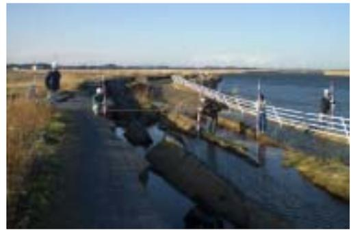
平成23年3月11日に発生した東日本大震災により、涸沼湖岸では堤防の崩壊や護岸の崩壊等、湖岸延長22kmのうち14.6kmにわたって被害が確認されました。このような状況の中、被災箇所を早急に復旧しなければ、降雨等による出水で甚大な被害が生じる恐れがあったことから、茨城県では、早急に応急復旧工事として、応急盛土等を実施するとともに、平成23年11月より本復旧工事に着手し、平成24年7月までに事業を完了しました。
