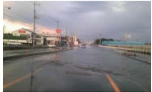
付けにあることから、早期の復旧、供用が急務とされました。今回の強い地震動により、地下水面下に堆積する沖積砂質土層及び埋立砂質土層が液状化を起こし、特に液状化は砂質土層が厚く堆積した瀬上川右岸側の区域で激しく起こりました。路盤への貫入、破壊がまず始まり、構造物の弱部より噴砂、陥没、沈下並びに路面の波打ちが生じていました。交通への長期的遮断が許されないため、被害の小さい下り車線を対面交互通行で暫定供用させるとともに、液状化対策による災害申請を行い、平成23年12月に本復旧着工し、平成24年7月には暫定的4車線の供用開始を行い、平成25年3月10日に復旧工事が完了しました。
