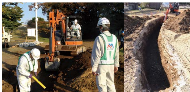
小型ICT建機（後付けMGシステム）による床堀作業検証状況
