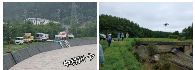
緊急排水状況（青森県）
