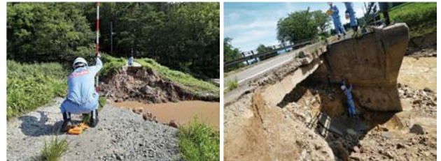
被災現場におけるTEC-FORCE活動状況
