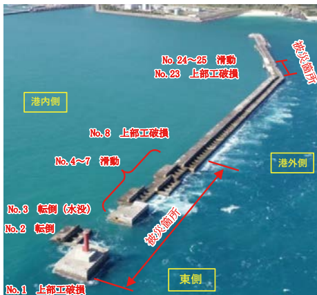
被災状況写真
