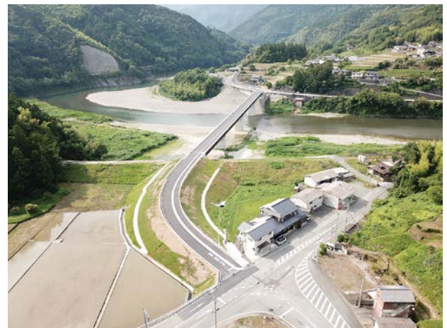
完成した大成橋（左岸側より）
