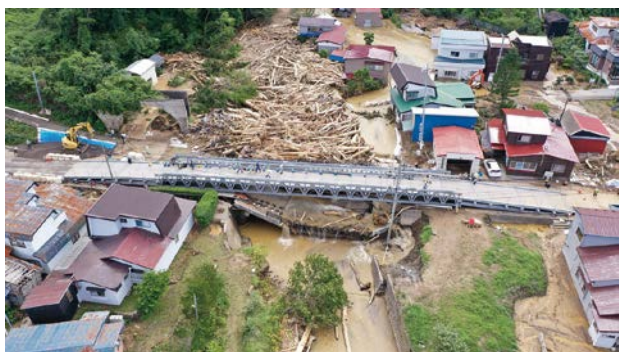
被災後の仮橋設置完了状況
