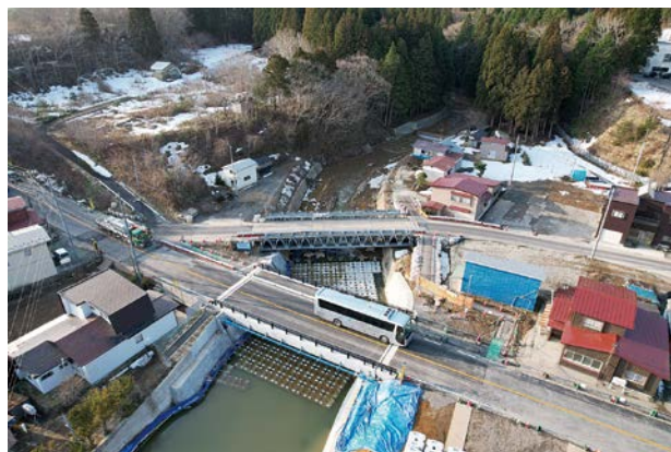
完成した小赤川橋の一般車通行状況
