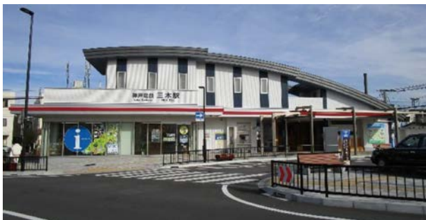
神戸電鉄三木駅の新駅舎
