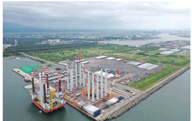
SEP船による風車部材の荷役状況
