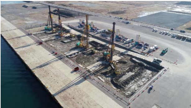
深層混合処理工法の施工状況
