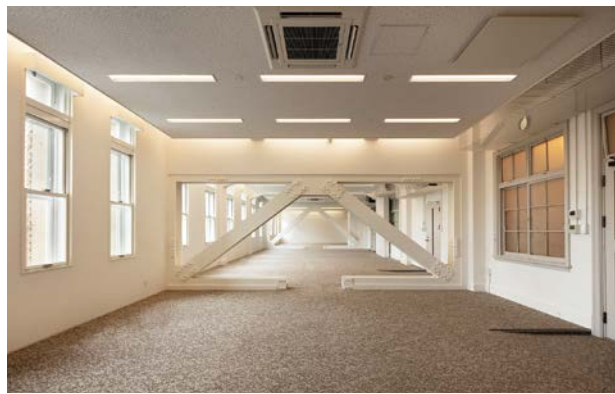
鉄骨ブレースにより補強した執務室
