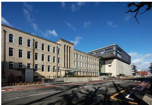
本館と新行政棟（竣工後）
