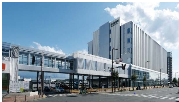
庁舎外観（東側・スカイウォーク）
