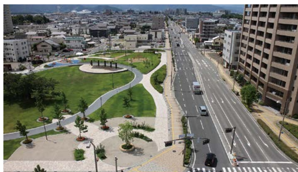
無電柱化した幹線道路と都市防災機能を備えた近隣公園
